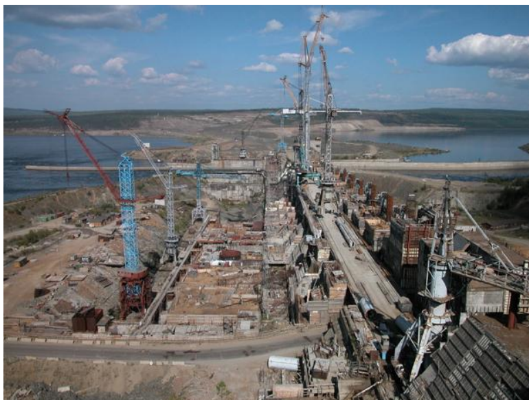
Стройплощадка Богучанской ГЭС в начале 2000-х годов
