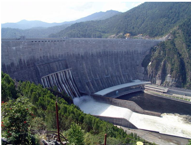
Эксплуатационный водосброс Саяно-Шушенской ГЭС в действии (2010)
